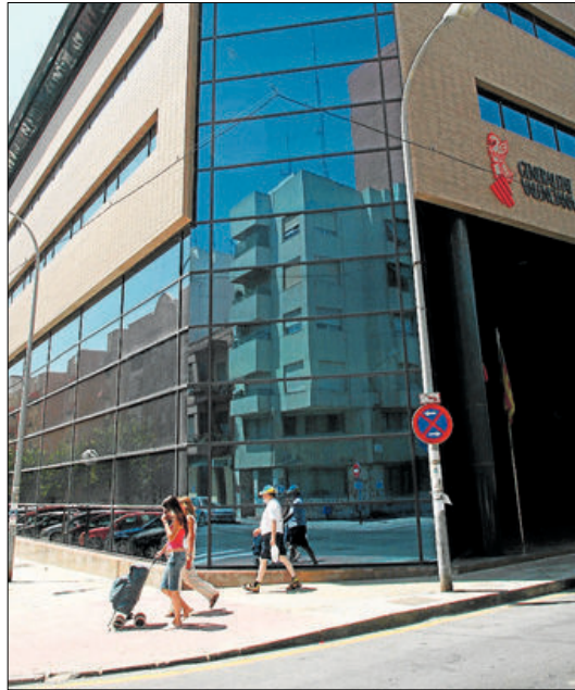
Edificio que alberga los juzgados de lo Mercantil de Alicante. C. DE MIDDEL
